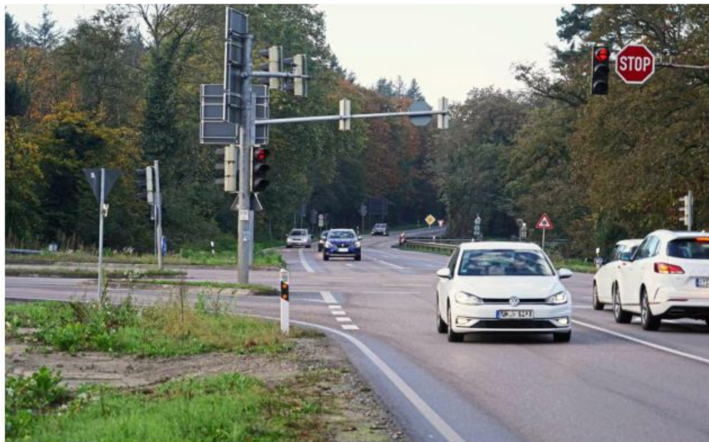
Hier geht ab Januar in Fahrtrichtung Süden nichts mehr: Die L75 (frühere B36) wird dann ab der Kreuzung der B500 wegen Brückenbauarbeiten bis Hügelsheim gesperrt. Damit wird auch diese Verkehrsader Richtung Baden-Airpark gekappt. Foto: Hans-Jürgen Collet
